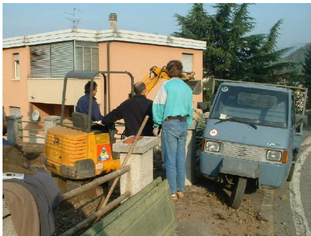
LAVORI IN CORSO AL MONUMENTO DI TRECALLO
